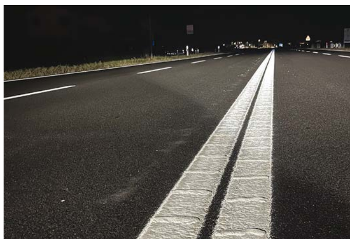
9. Il lavoro svolto lungo la S.R. 354 "di Lignano"
