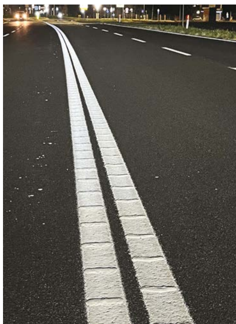
6. La segnaletica posata sulla S.R. 354 di Lignano
