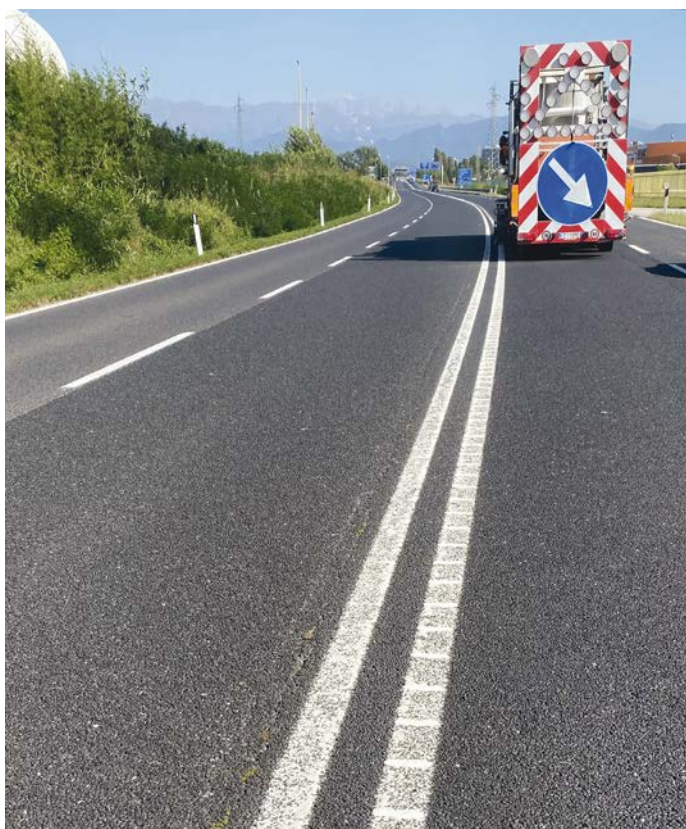
4. La fase di posa sulla S.S. 13 "Pontebbana"
